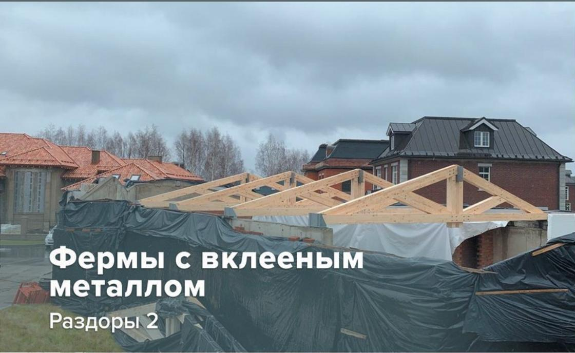
**Фермы с вклеенным металлом**
